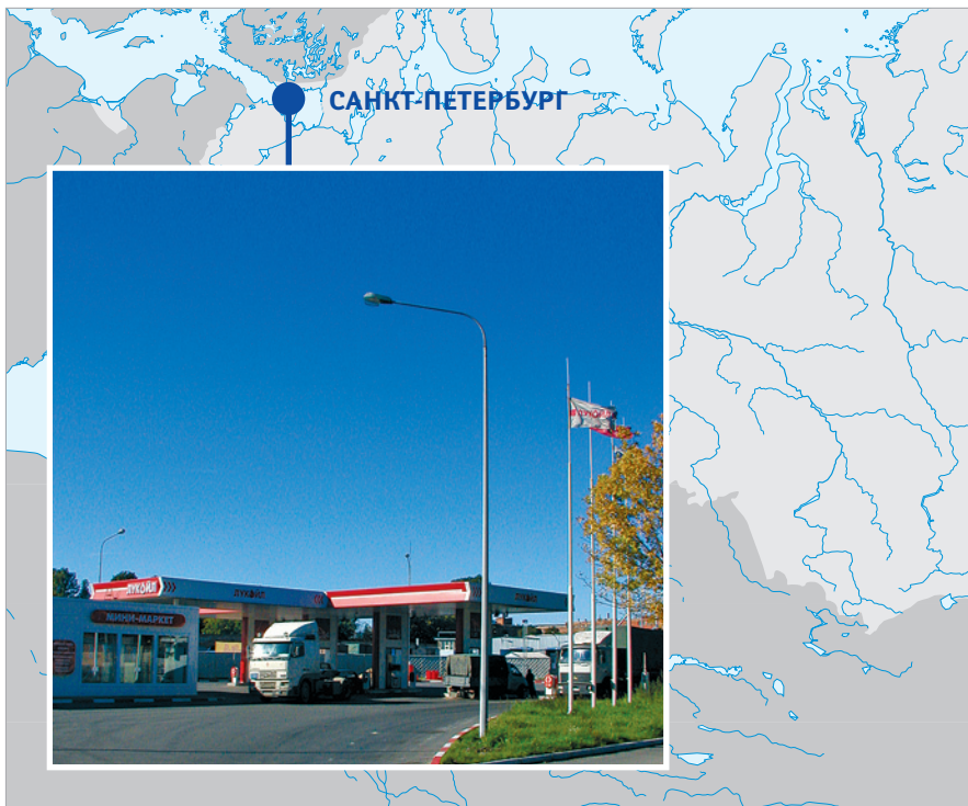
Санкт-Петербург. Освещение АЗК «ЛУКОЙЛ»
