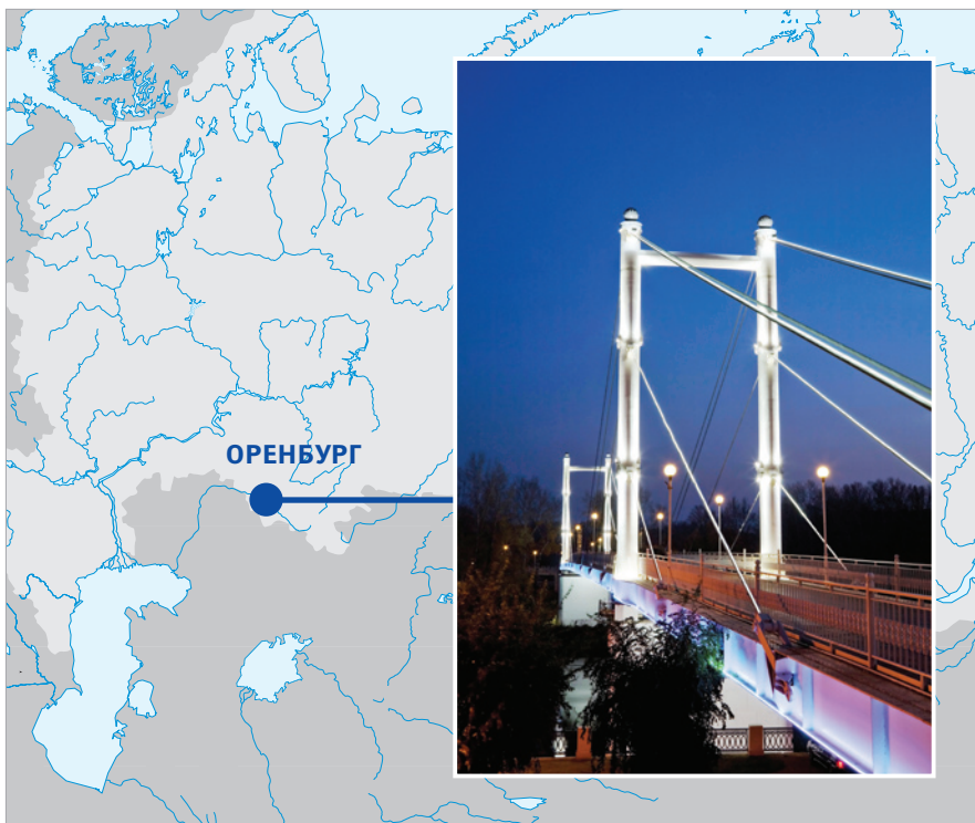
Оренбург. Архитектурно-художественная подсветка пешеходного моста через р. Урал
