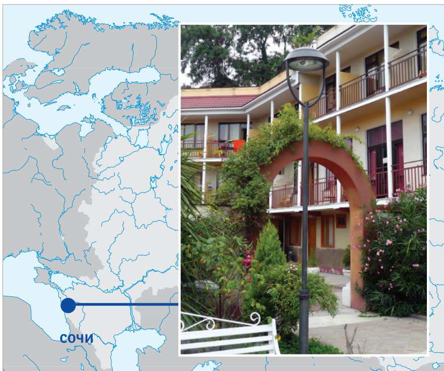
Сочи. Освещение территории санатория
