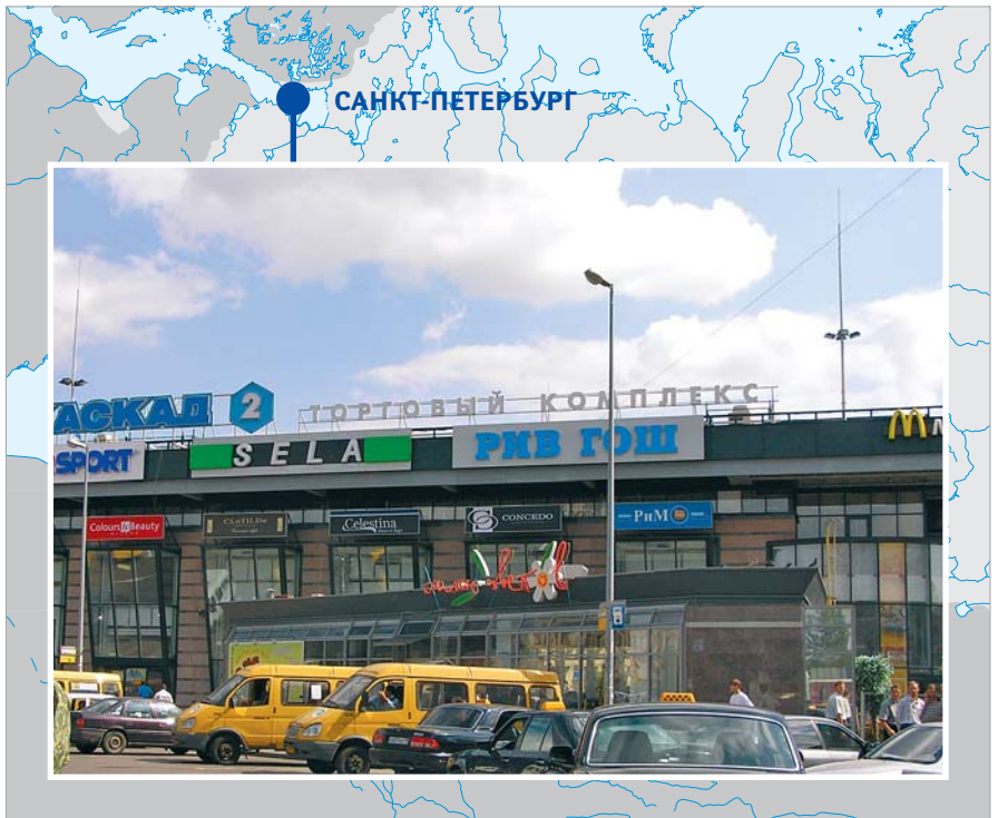
Санкт-Петербург. Молниезащита ТК «Заневский каскад»
