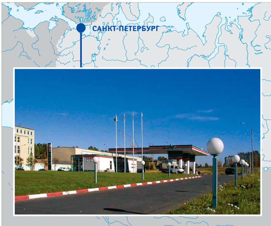
Санкт-Петербург. Освещение АЗС
