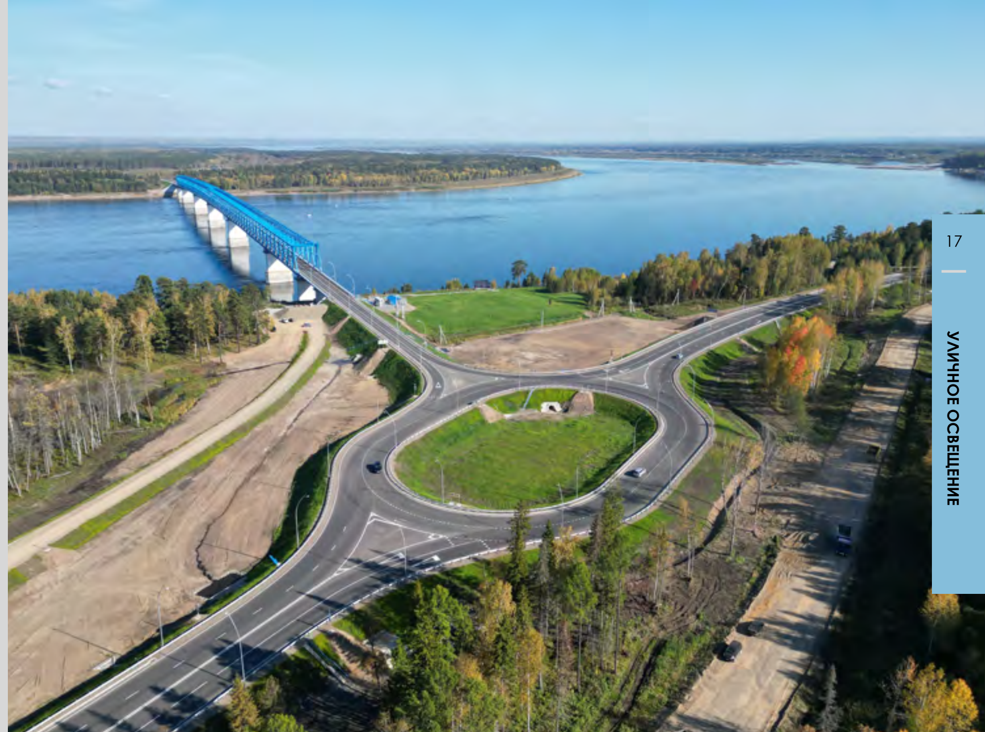
Высокогорский мост, самый северный мост через Енисей. Подъездная дорога к мосту. Красноярский край
