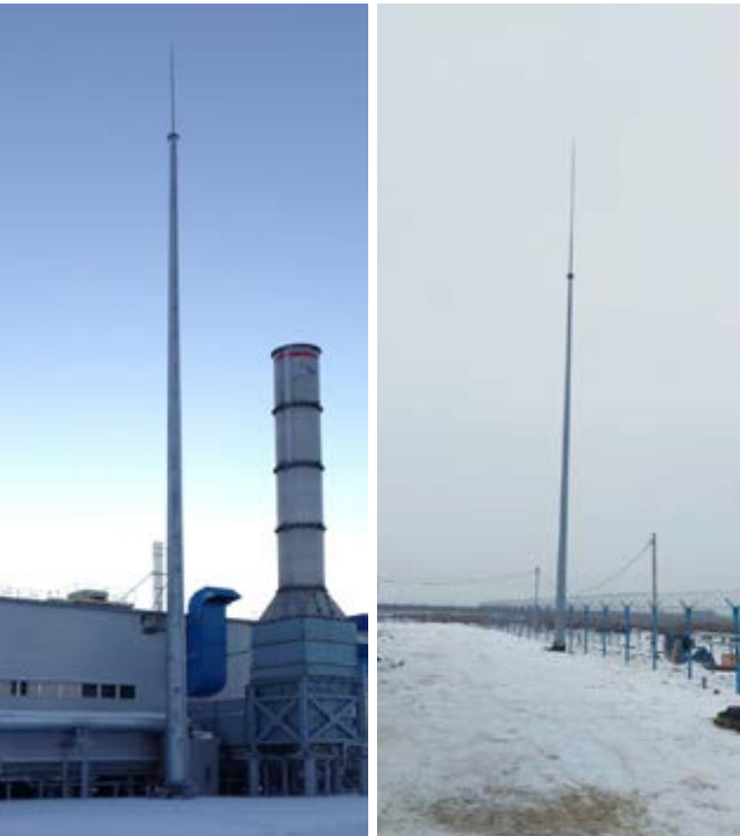
Внешний вид МОГК (без системы защиты) КС «Байдарская», ЯНАО
