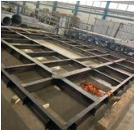
Фото с контрольной сборки на заводе «Мегаполис» (ГК «АМИРА»)
