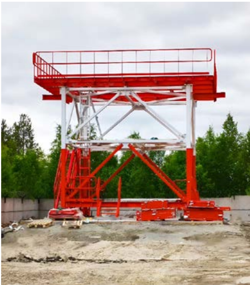
Фото с монтажа в аэропорту, Мурманская область
