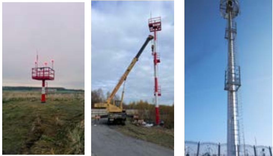
Примерный вид мачты (количество лестниц и площадок отдыха зависит от высоты конструкции)
